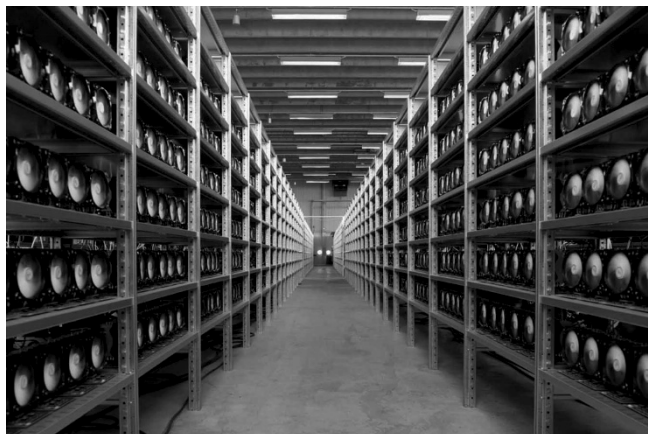
Slika 2. Izgled BitKoin postrojenja [4]
